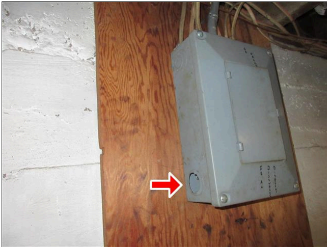
4.2 Item 1(Picture) Open Slot (Sub Panel)
